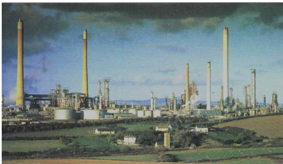
Рис. 6.2. Загальний вигляд нафтопереробного комплексу
