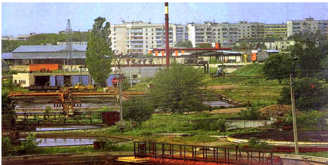
Рис. 12.11. Загальний вигляд комплексу очисних споруд
